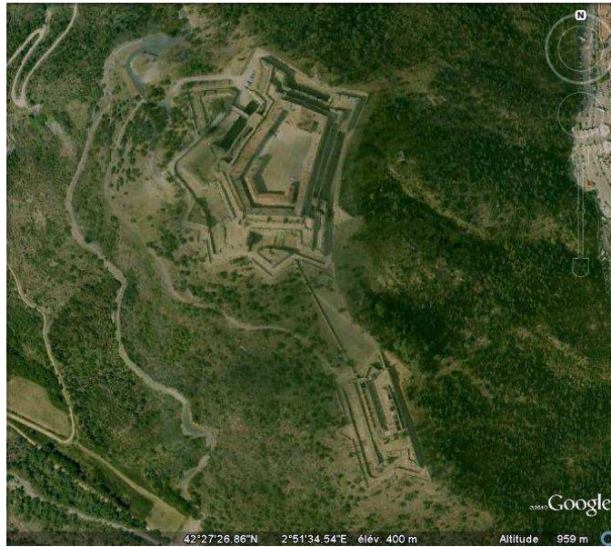
Vue aérienne du fort de Bellegarde, GoogleEarth, 13/07/2010.
