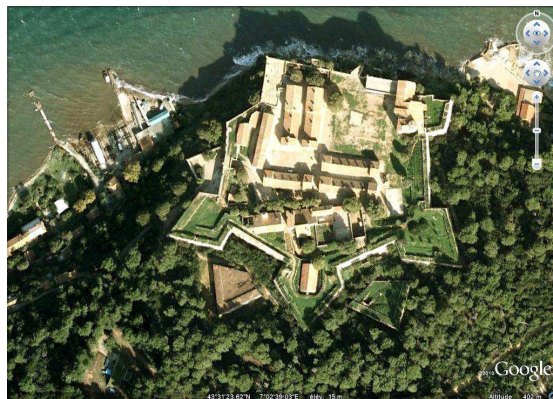
Vue aérienne du fort Sainte-Marguerite, GoogleEarth, 29/08/2010.
