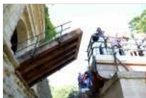
Mise en action du pont-levis de la demi-lune de la porte de France à Longwy
