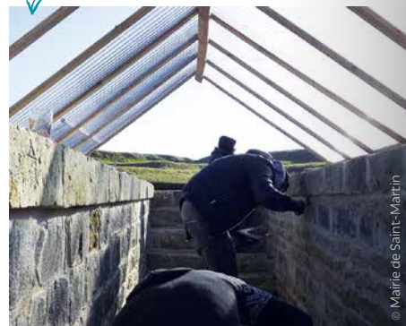
Rejointement de l'escalier de la demi lune Saint-Louis
