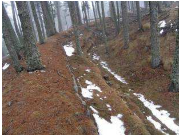
Batterie de la Forge, banquette de tir
