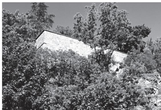
Les arbres matures, en plus de bloquer des vues significatives, nuisent à la stabilité de l'escarpement.
