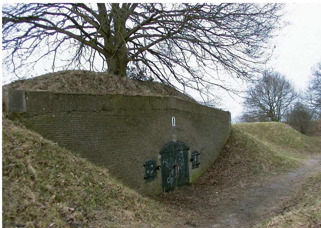
1 Grand arbre qui absorbe l'eau et tient ainsi le sol sec. Casemate au bastion Promers . (RGD 2006)
