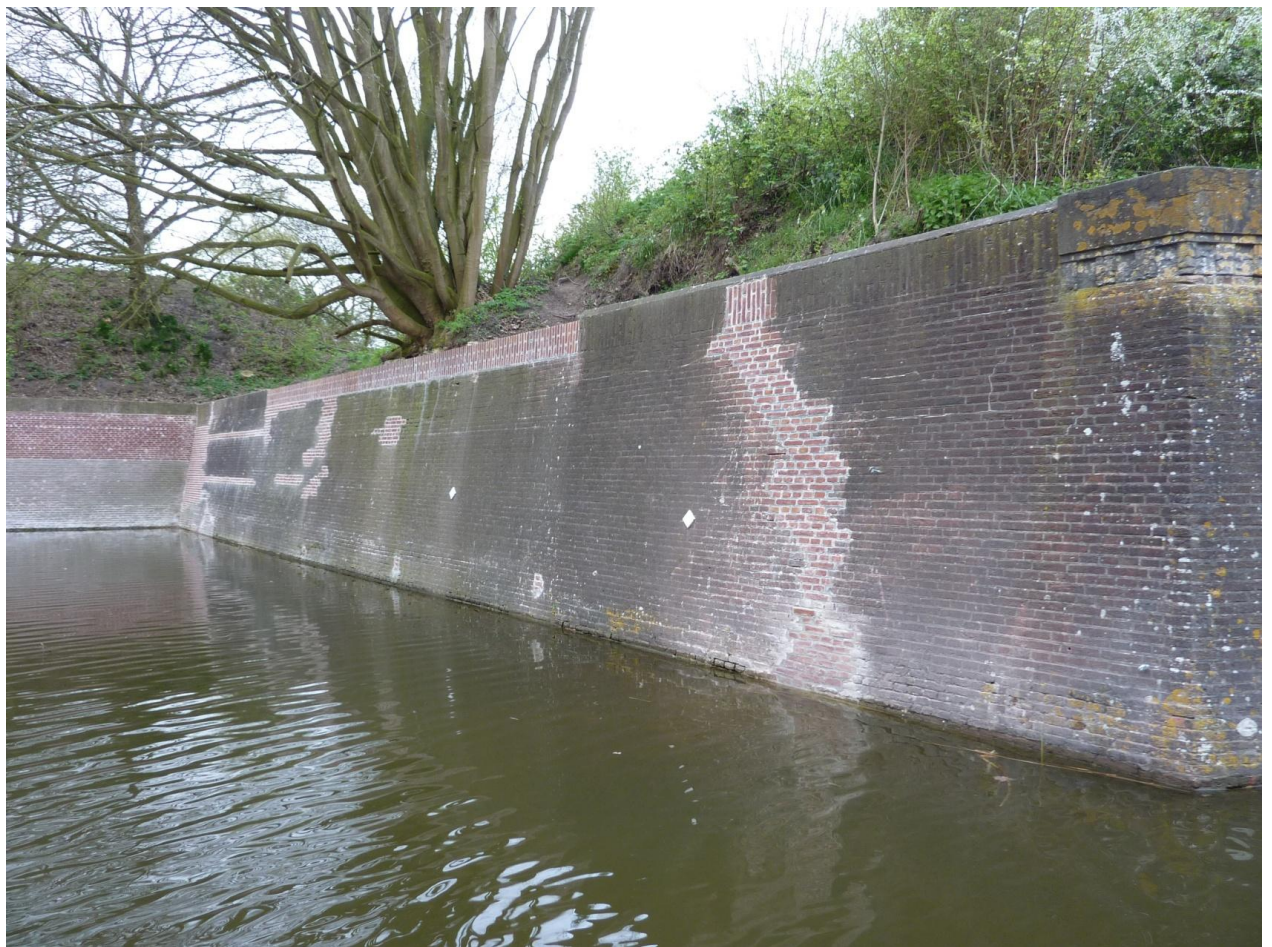
Flanc droit du bastion Katten après la restauration. (RGD)
