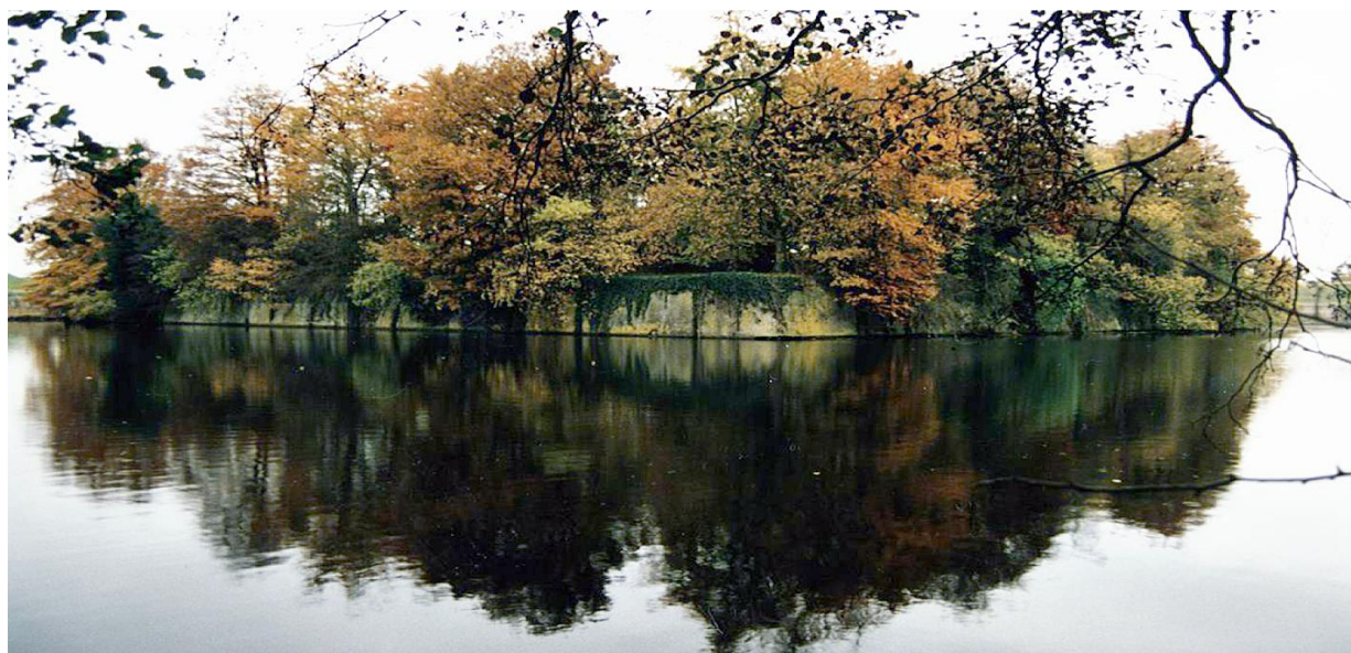
40 Teintes automnales. Demi-lune 6 entre les bastions Oranje et Promers avant la restauration. (RGD)
