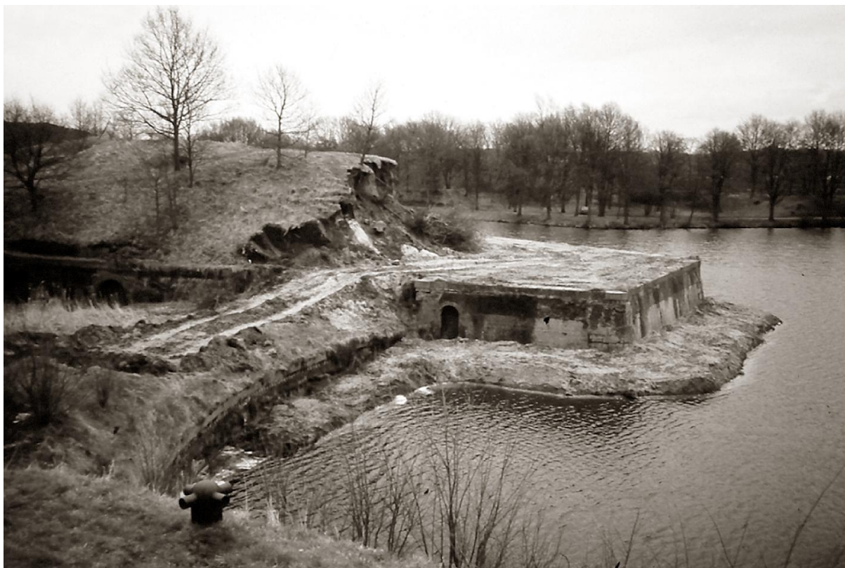
14 Au bastion Oranje aussi, la terre des terrassements a été déstabilisée lorsqu'elle a été déposée temporairement dans la douve. (RGD 1980)
