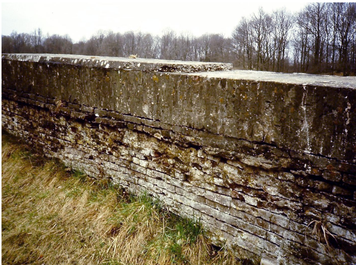
26 Côté intérieur du mur de la courtine entre les bastions Oranje et Katten . Recouvrement de la crête par du béton et par un enduit de mortier. (RGD, 2003)
