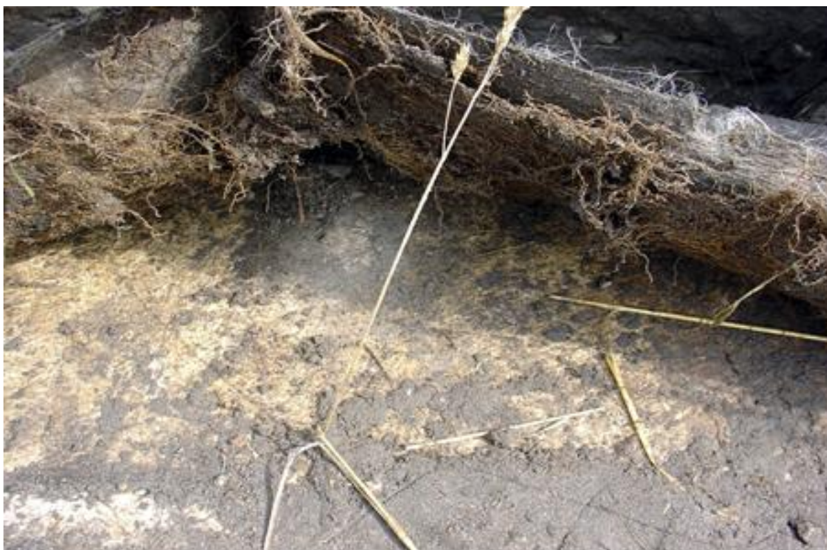
34 Cette membrane bitumeuse et étanche s'est détachée et livre aux racines un passage libre vers le sous-sol nutritif. (André Hoek)
