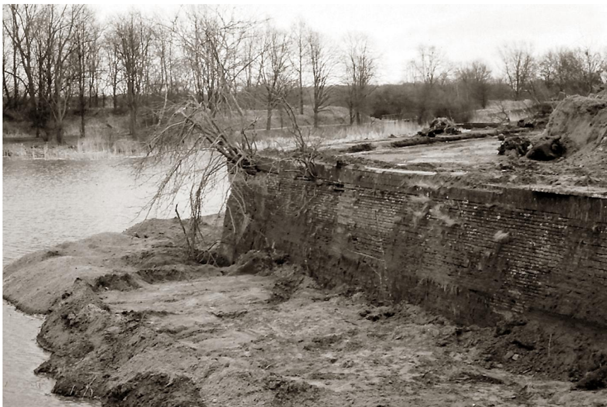
7 La terre des terrassements a été déstabilisée lorsqu'elle a été déposée temporairement dans la douve. (RGD 1975)
