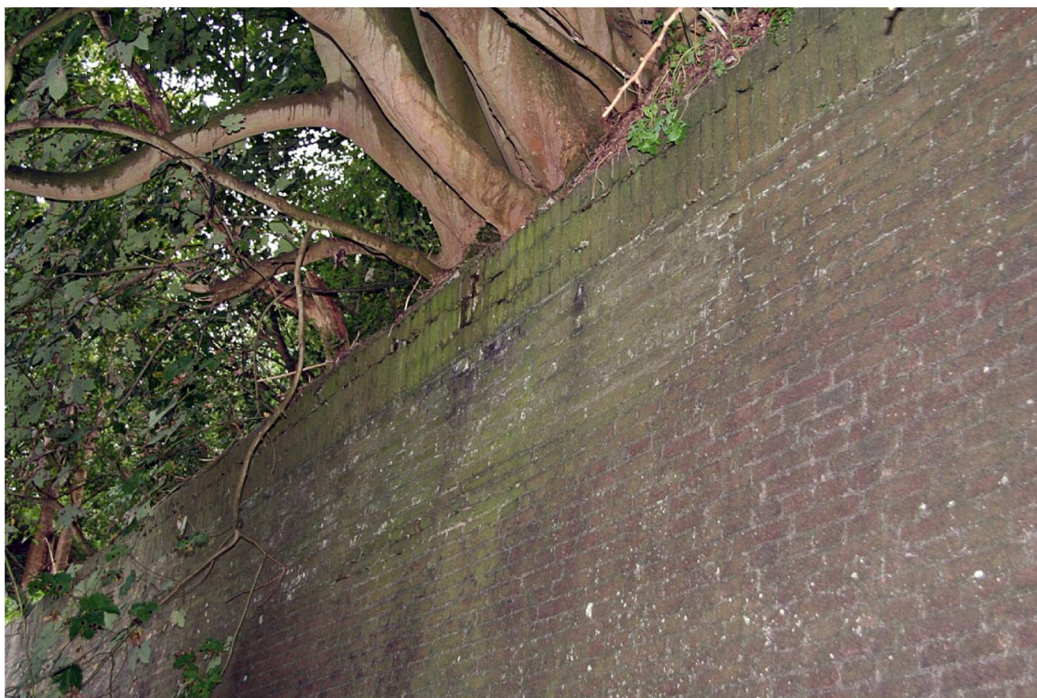
30 L'arbre sur le mur de revêtement ne s'enracine pas dans la maçonnerie mais dans le sol derrière le mur ; l'arbre ne cause donc pas de dégâts au mur mais au contraire, il tient le mur sec. Bastion Katten , flanc de droite. (RGD)
