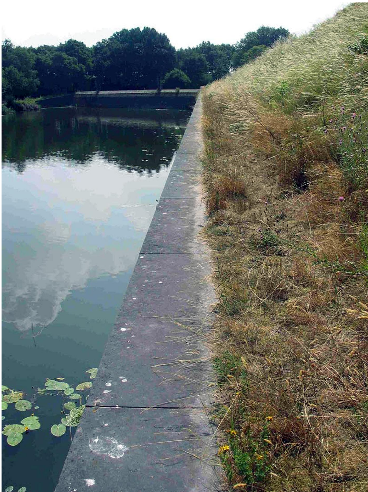
35 Les dalles en pierre bleue sont humides par l'action capillaire du mur qu'elles recouvrent, sauf du côté du terrassement. Là, la végétation deshydrate la pierre ce qui cause les taches claires et sèches à la surface de la pierre. Détail saillant : pendant l'été sec du mois d'août 2006, l'herbe était verte seulement le long de la pierre humide, tandis qu'ailleurs toute la végétation était fanée. Bastion Oranje , face de gauche. A l'arrière plan, un des deux batardeaux avec deux dames. (RGD)
