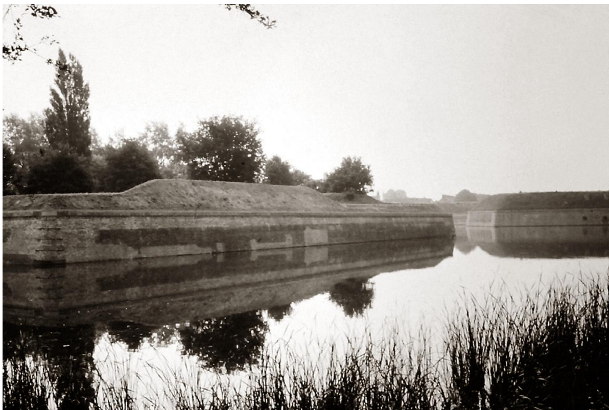
4 La demi-lune no. 6 devant la courtine entre les bastions Oranje et Promers . Les réparations au mur de revêtement sont bien visibles. (RGD)
