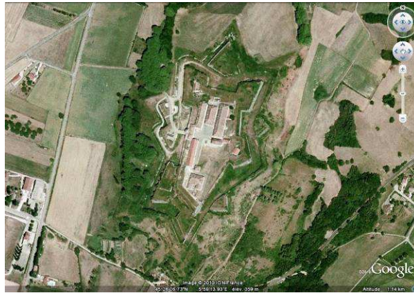
Vue aérienne du fort Barraux, GoogleEarth, 27/07/2010.
